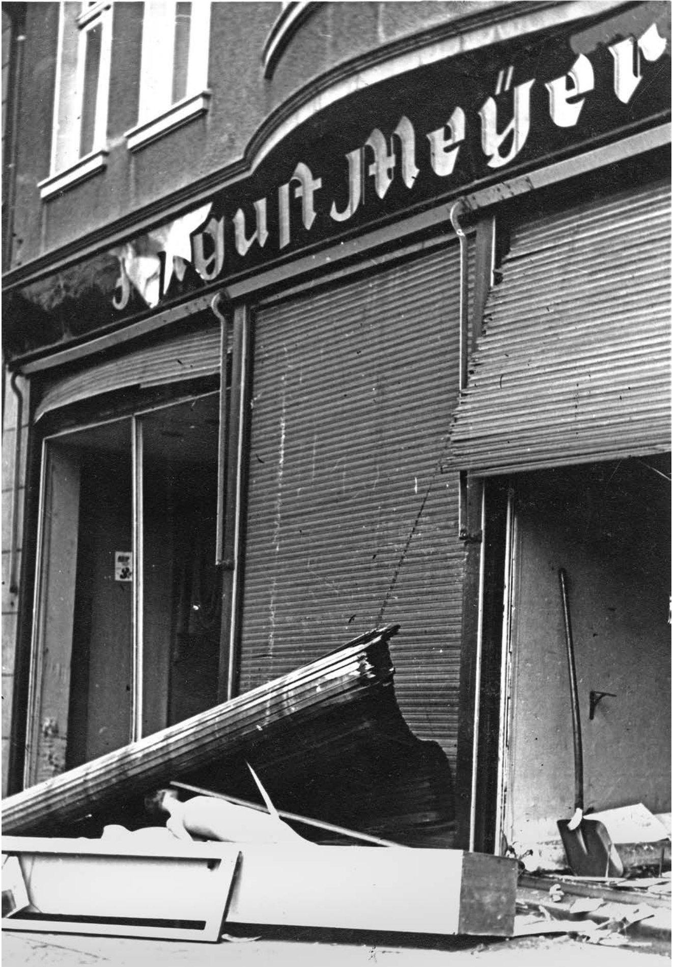
Dieses Foto vom zerstörten Haus Gladbecker Straße 334 entstand am Tag nach der Pogromnacht.
