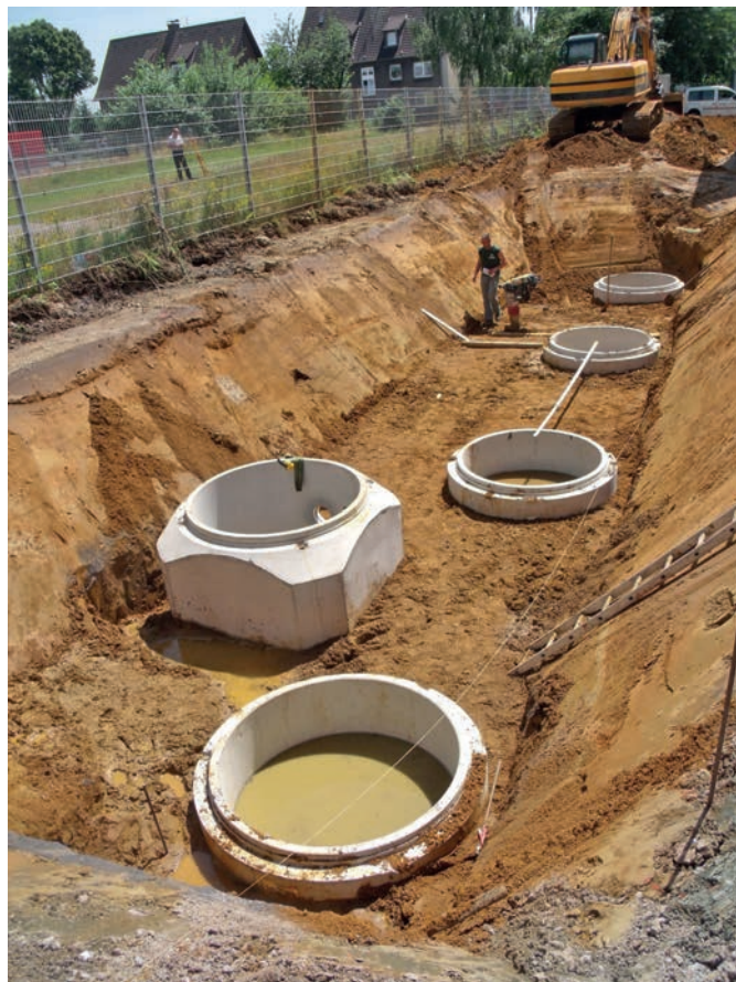
Abbildung 14: Unterirdische Speicherelemente (Stadt Bottrop, BEST AÖR 2025)
