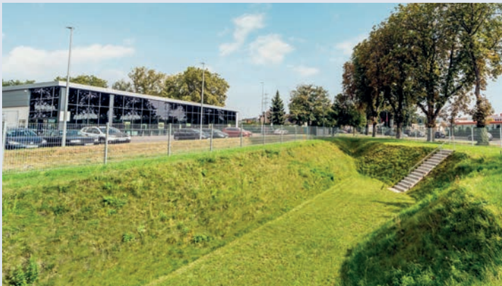
Abbildung 11: Regenwasserrückhaltebecken (EGLV 2025)
