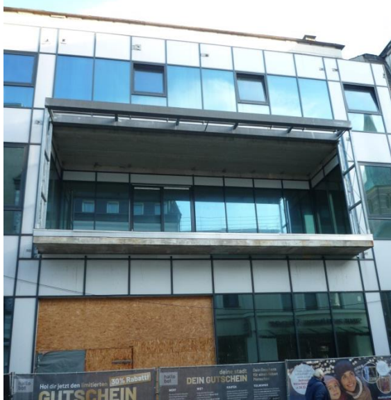
Abbildung 55: Baustellenzustand großflächiger Einzelhandelsstrukturen (Hansazentrum)
