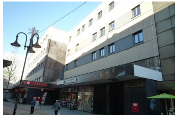
Abbildung 56: Gebäudestruktur und Fassaden der 1960er Jahre an der östlichen Seite der Hochstraße
