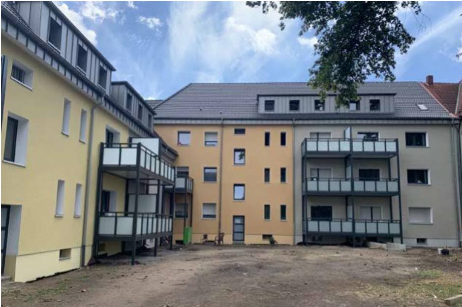
Beispiel Altbausanierung: Maßnahme der Gesellschaft für Bauen und Wohnen im Bereich Scharnhölzstraße / Germaniastraße
