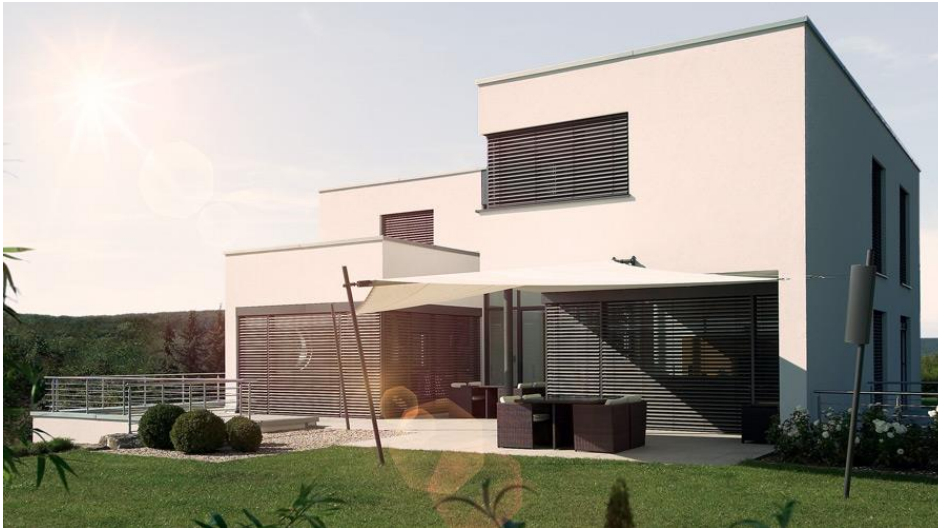
Beispiel Sonnenschutz: Kombination aus heller Fassade (siehe Kapitel 4.6), Sonnensegel und Außenjalousien
