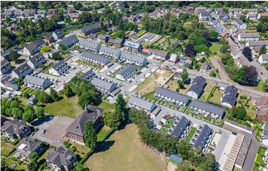
Beispiel Flächenrecycling: Bebauung einer ehemaligen Gewerbefläche im Bereich Heilmannstraße/Bergendahlstraße mit 91 Reihenhäusern
